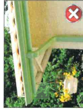
Descentes d'eau pluviales de couleur
