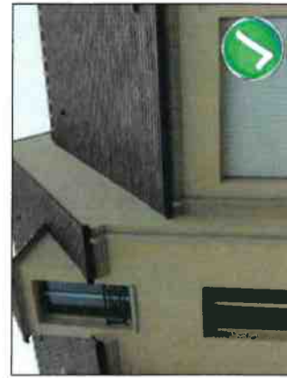
Descentes d'eau pluviales ton Sable
