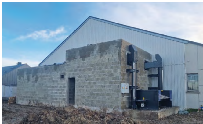
Chaudière biomasse en construction
