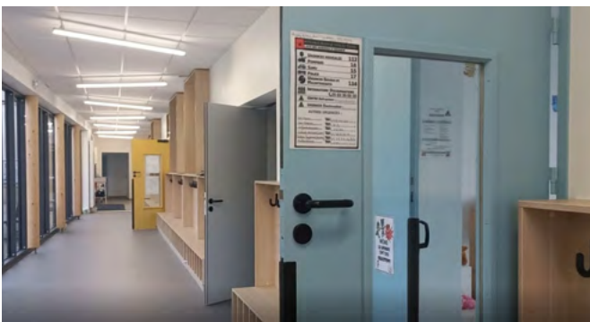
Remise aux normes des locaux
